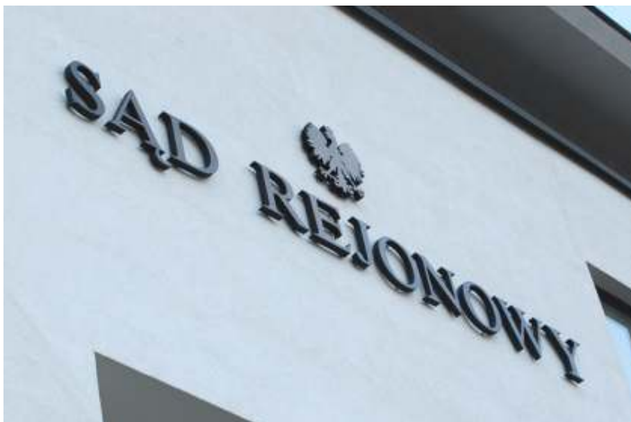
Sąd Grójec - Znaki na elewacji - styrodur na dystansach
