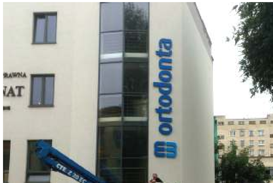
Ortodonta - Znak na elewacji styrodur klejone do tynku
