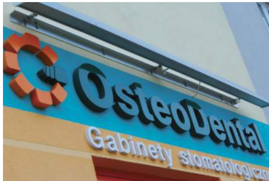
Stomatolog - Znaki styrodur + plexi klejone do elewacji tynkowej
