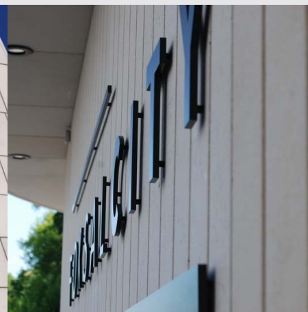
Znaki z pełnego aluminium na dystansach, kotwione do piaskowca.
