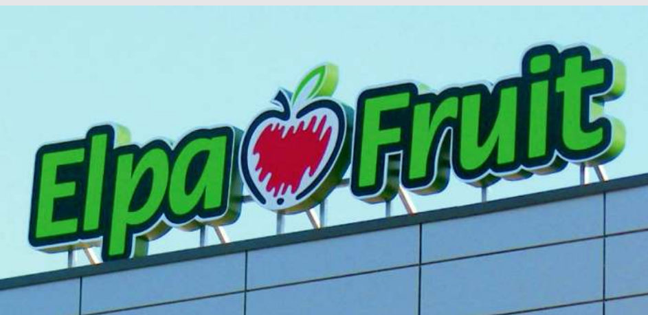
Znaki z plexi na konstrukcji stalowej.
