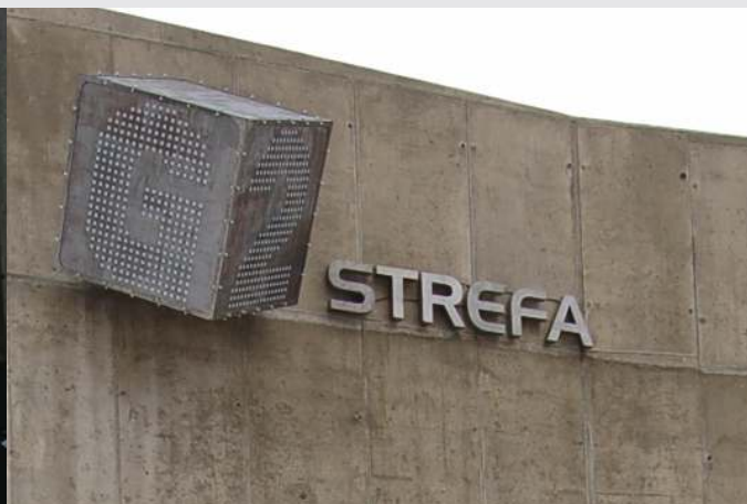
Znaki spawane ze stali czarnej - elewacja betonowa.
