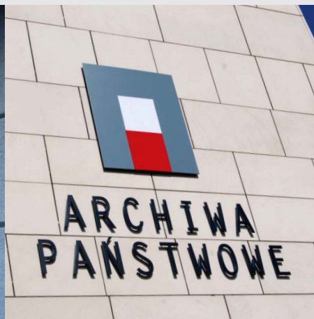
Znaki z pełnego aluminium na dystansach, kotwione do piaskowca.
