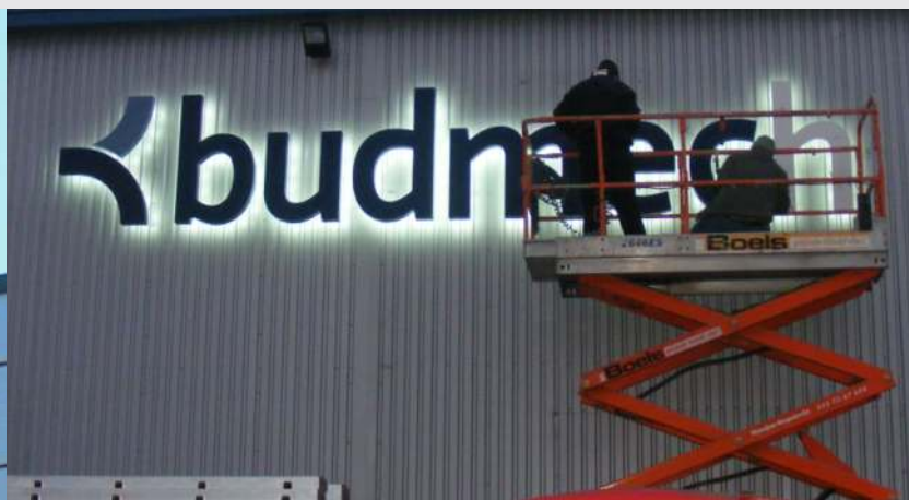
Znaki na elewacji z blachy powlekanej - montaż na kotwach dystansowych
