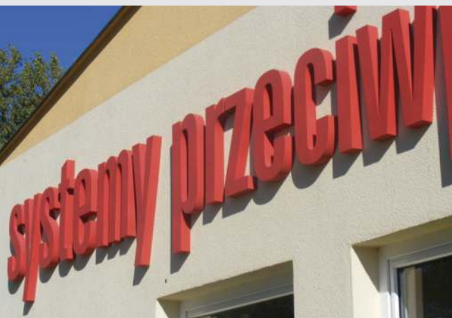
Znaki na elewacji styrodur - klejone do tynku
