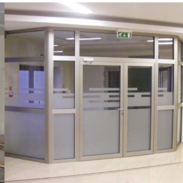
Centrum Konferencyjne Okopowa - Warszawa
